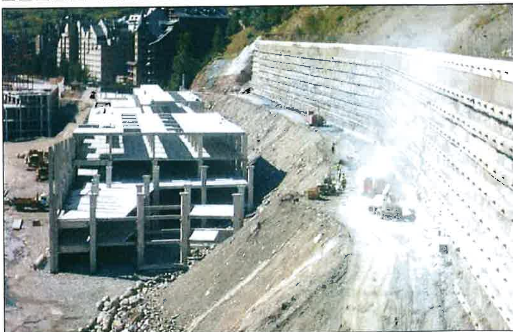
Imagen de archivo de las obras en el Valle de Ruda.
