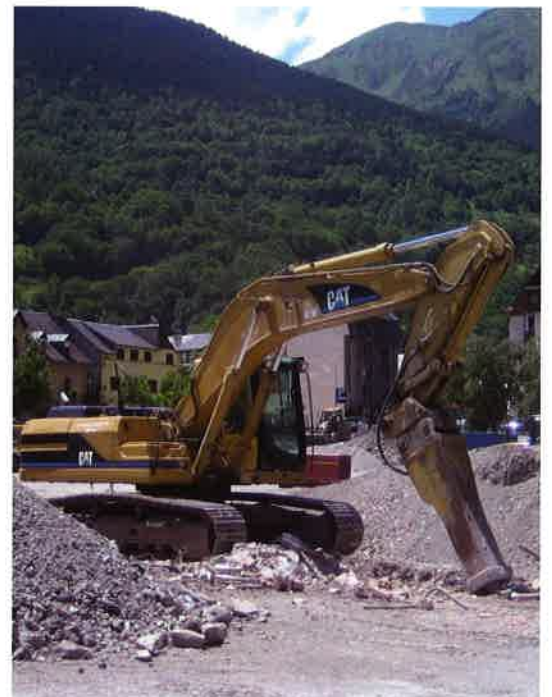
■ Obras de construcción del aparcamiento.
