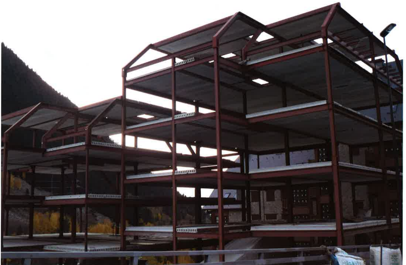
■ Estado actual de la urbanización del Valle de Ruda, con algunas obras paralizadas.
