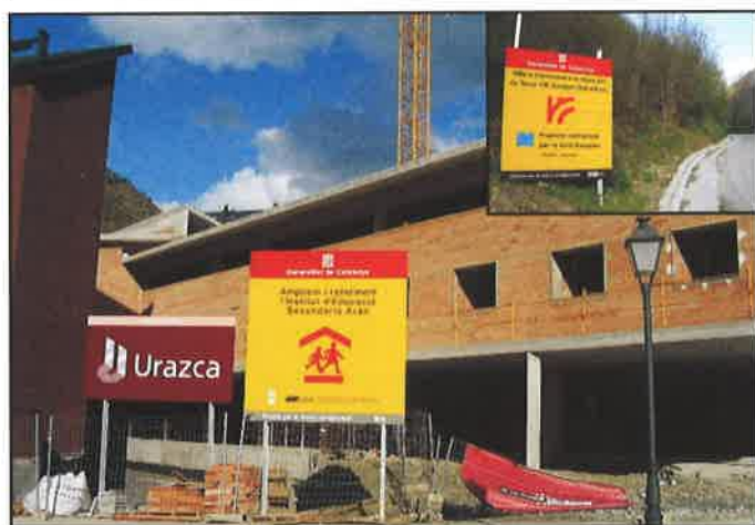
El IES d'Aran en Vielha. Arriba, mejora de la carretera del Toran.
